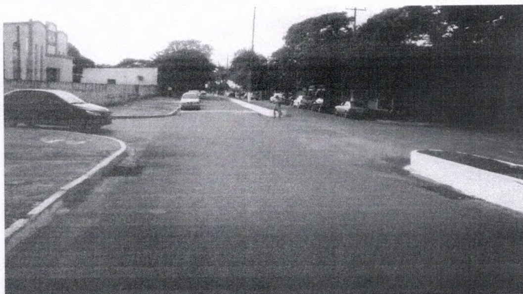
Figura 25 - Drenagem na avenida principal de Japorã
