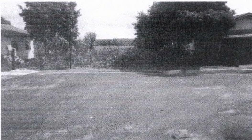
Figura 23 - Drenagem no final de ruas pavimentadas, sendo direcionadas diretamente para o pasto
