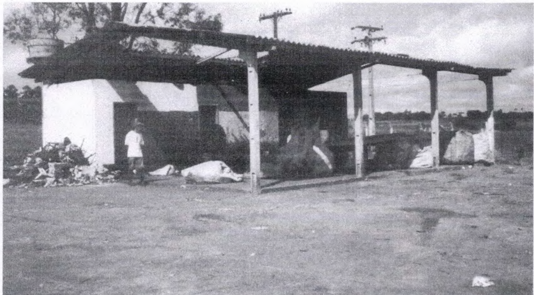
Figura 29 - Vista do depósito no lixão atual
