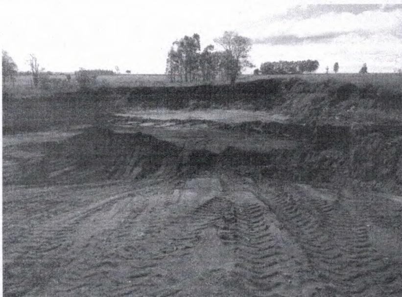
Figura 49 -Vala escavada para destinação de resíduos RCD (inertes).
